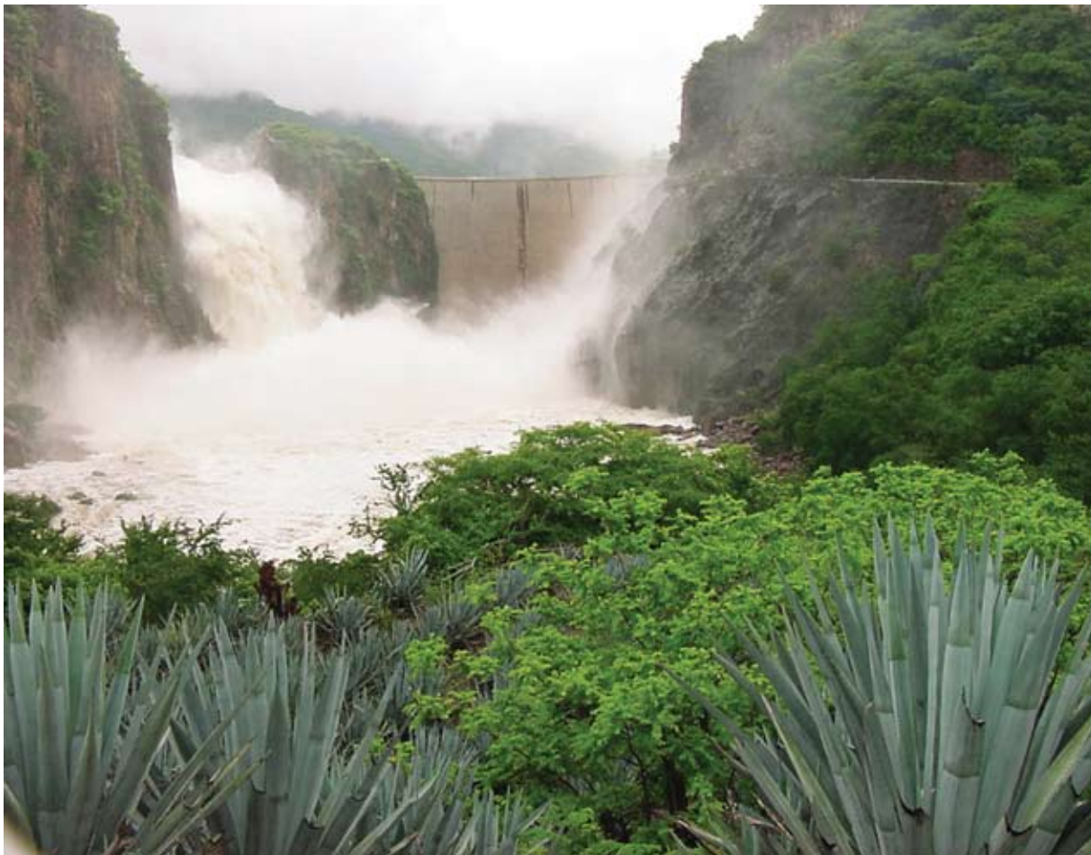
Presa Santa Rosa (98).
