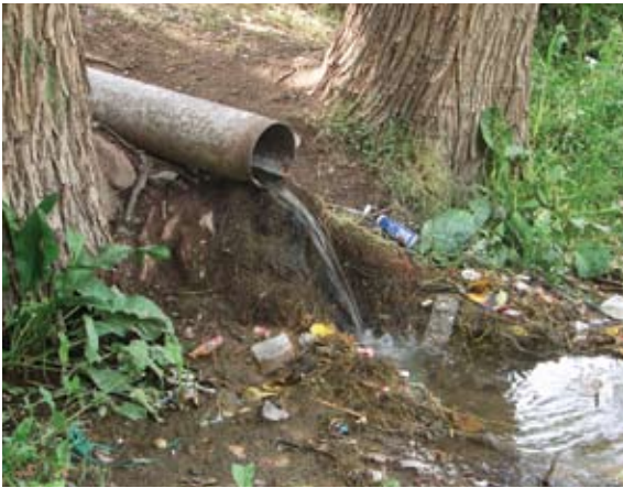
Basura y descargas de aguas residuales han contaminado la cuenca (121).
