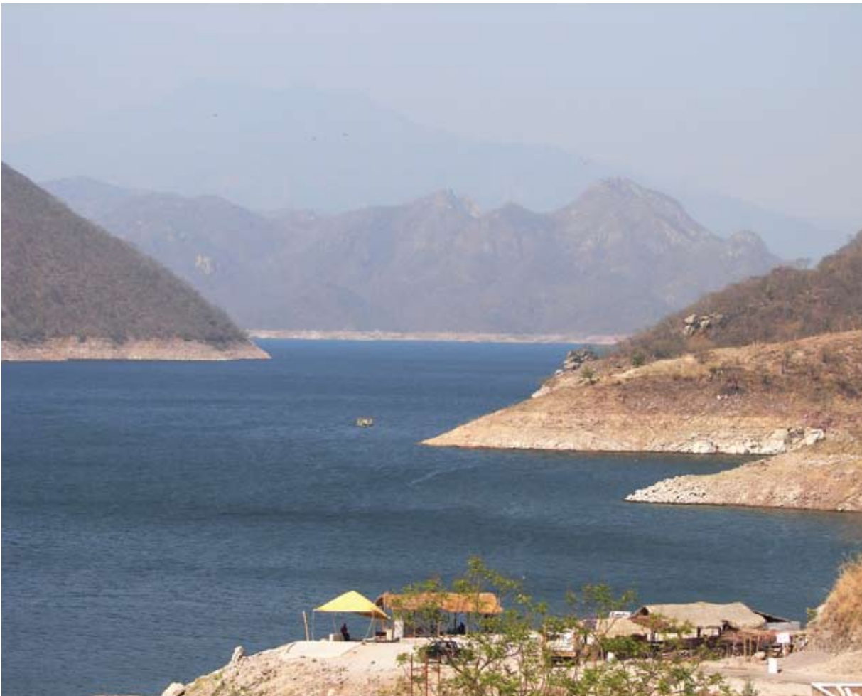
Embalse de la presa Aguamilpa, límite del municipio Del Nayar (78).
