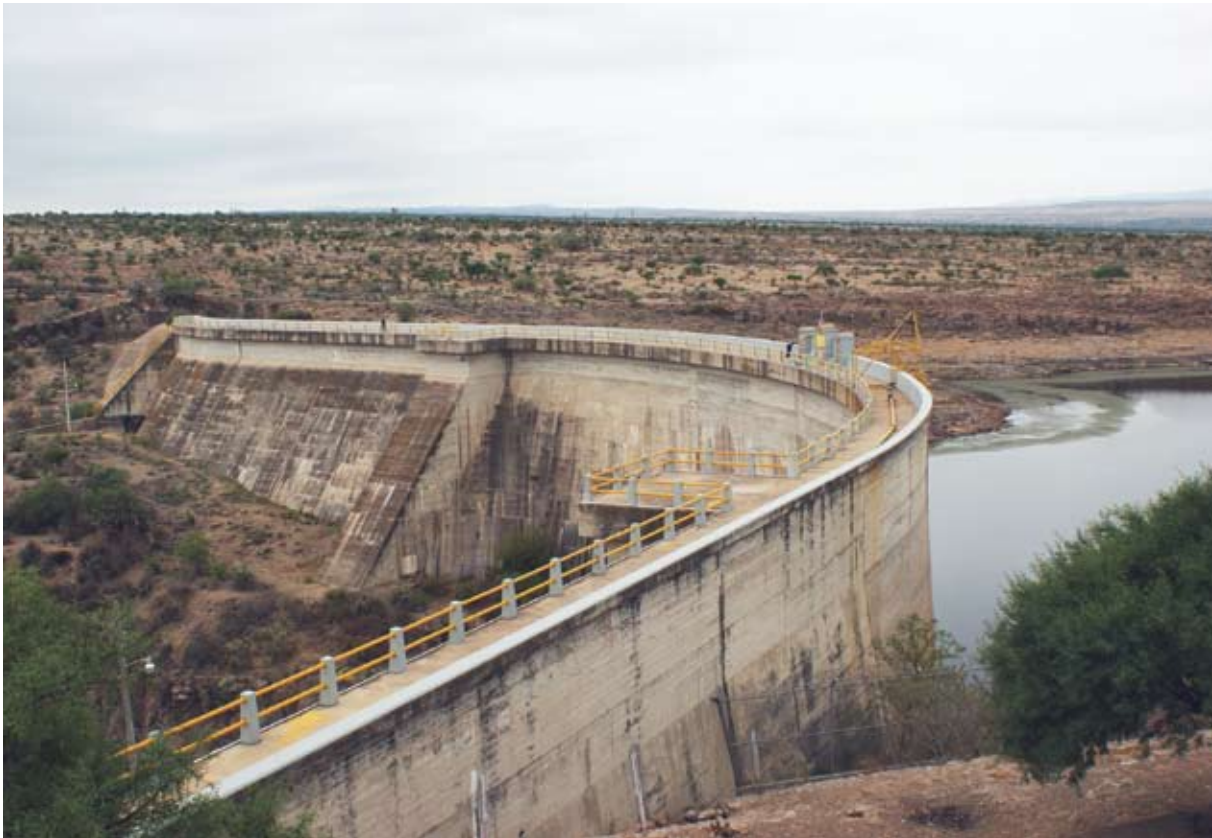
Cortina de la presa Plutarco Elías Calles, San José de Gracia, Aguascalientes (18).
