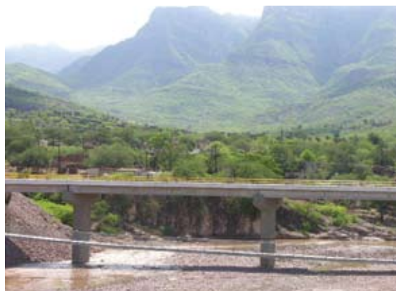
Puentes peatonal y vehicular sobre el río Huaynamota, en Sta. María Huazamota, Dgo. (68).
